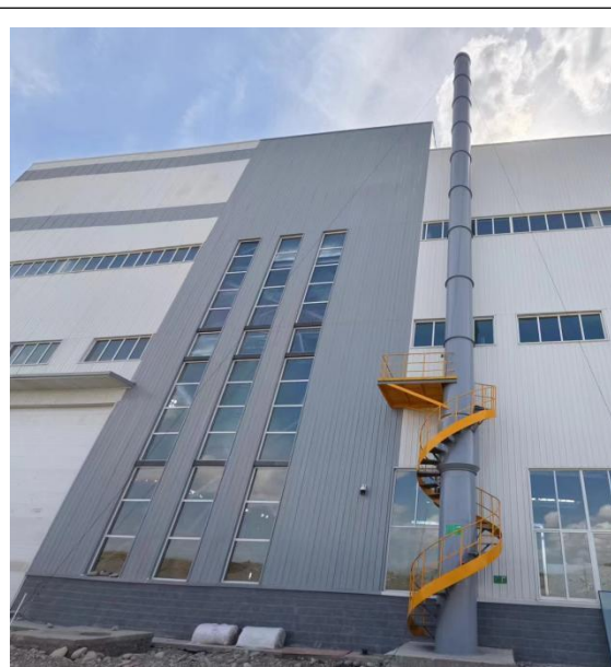
造型、制芯废气排气筒
